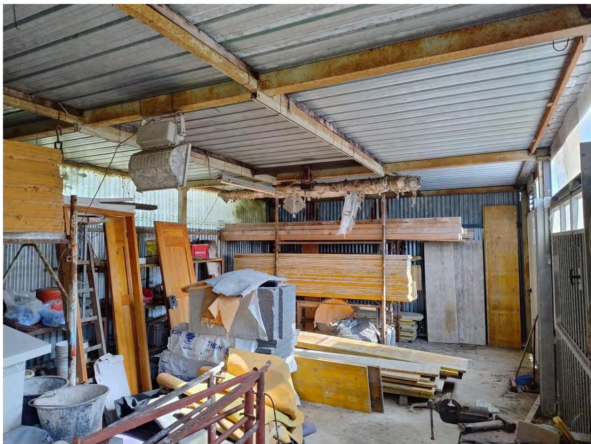
FOTO 6 Vista interna manufatto grande
