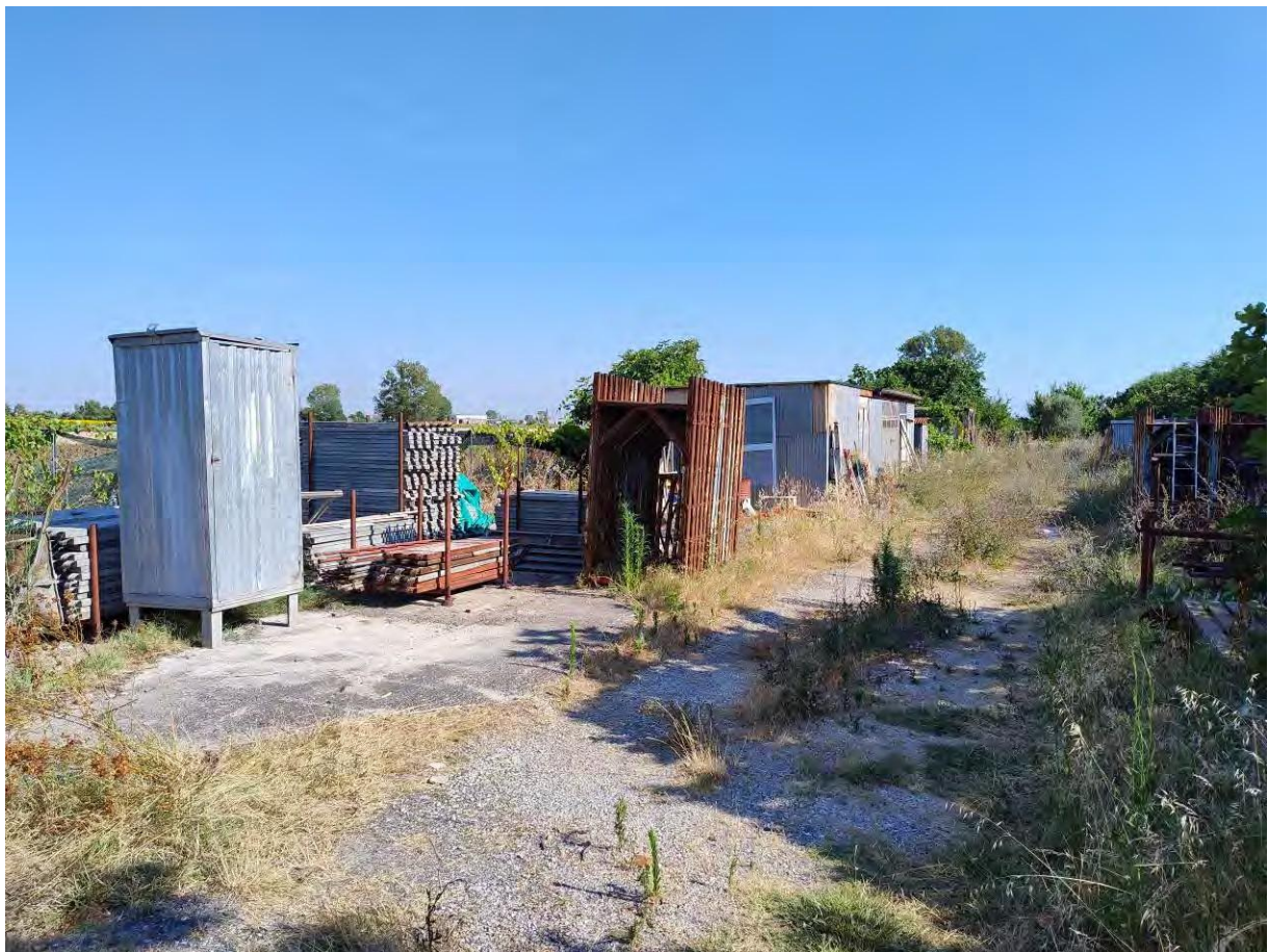
FOTO 2 Vista terreno e manufatti lato ovest da accesso carrabile
