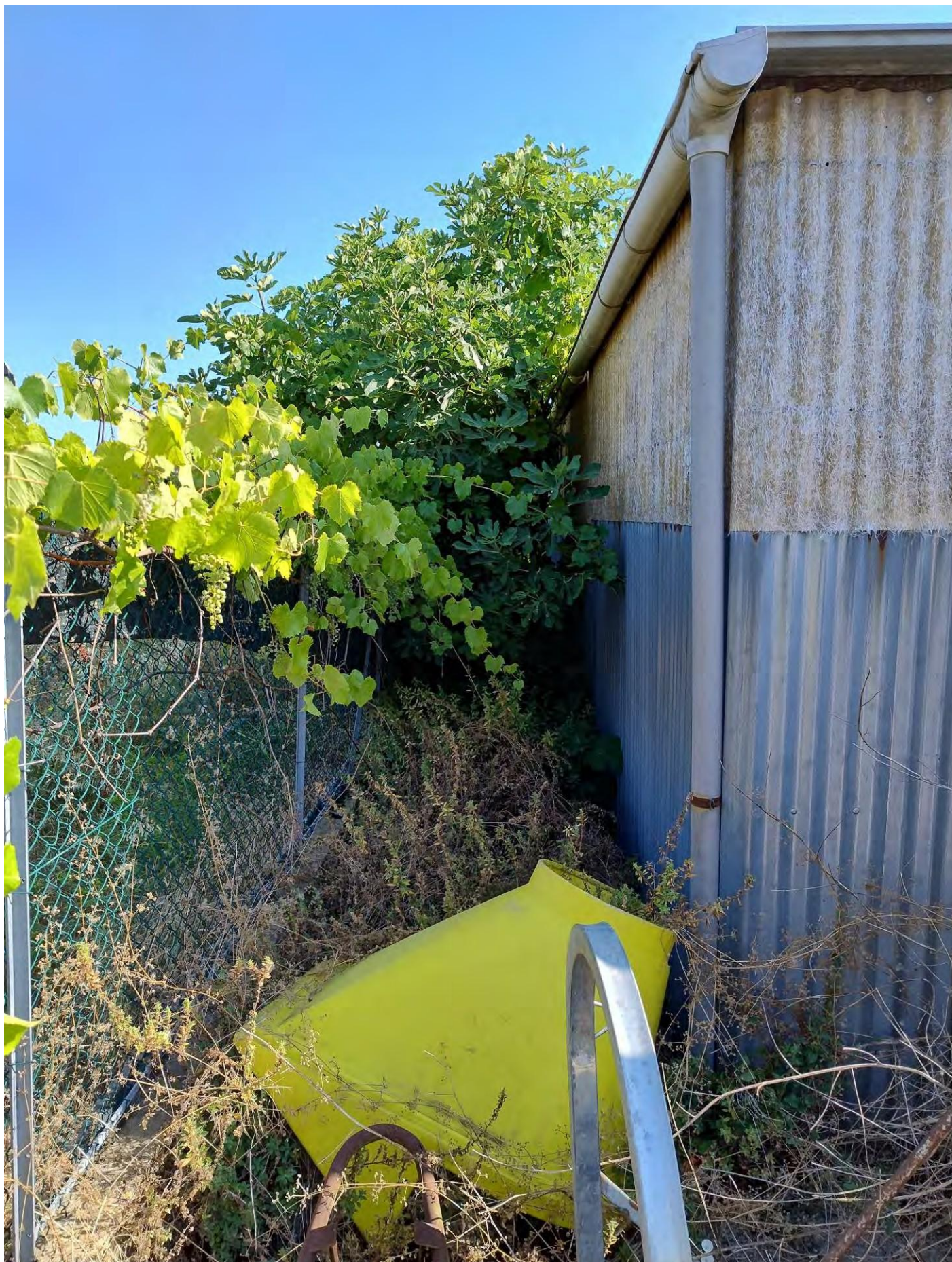
FOTO 9 Vista manufatto grande lato Ovest
